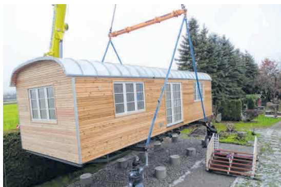
Mitarbeiter der Firma Schmiede Radsack aus Mecklenburg-Vorpommern helfen, den Wagen auf den Punktfundamenten zu platzieren.
